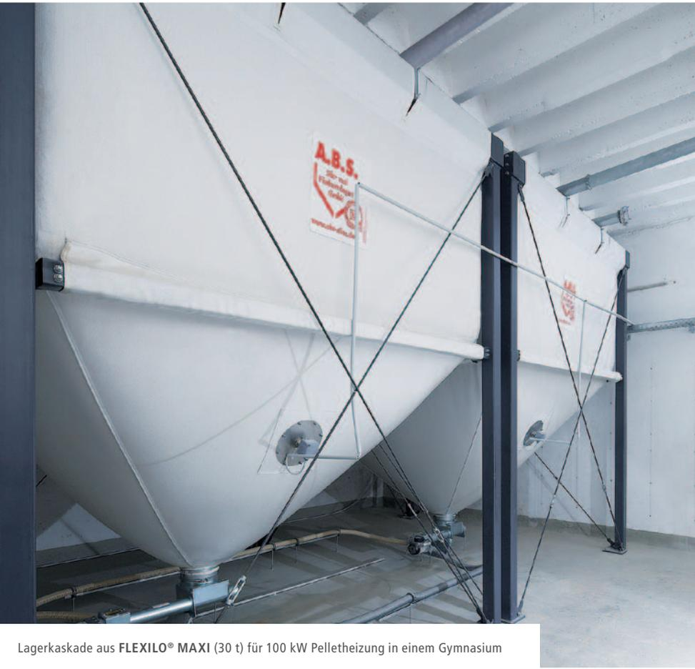
Lagerkaskade aus FLEXILO® MAXI (30 t) für 100 kW Pelletheizung in einem Gymnasium
